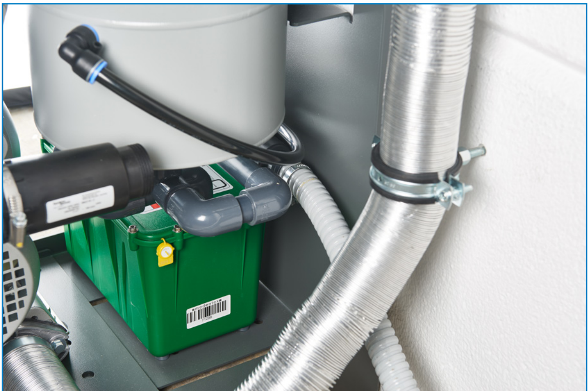
Abb. 8: Tankeinheit mit installierter Abwasserleitung
