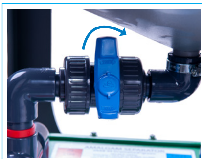
Abb. 89 Absperrhahn schließen
