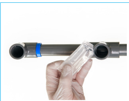
Abb. 127 Rohrenden der Auslaufbrücke einfetten
