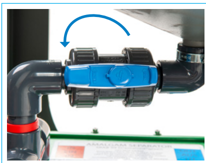
Abb. 105 Absperrhahn öffnen
