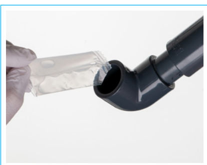
Abb. 126 Rohrenden der Zulaufbrücke einfetten
